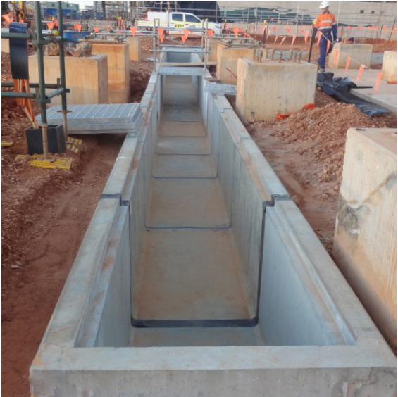
Precast units for LNG processing train
