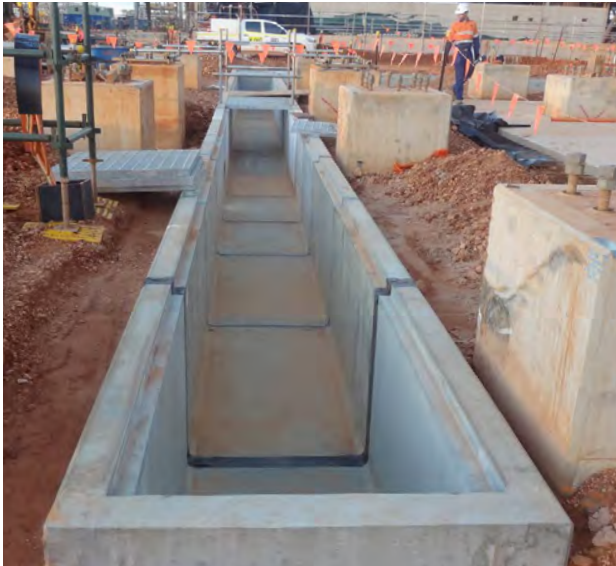
Precast units for LNG processing train
