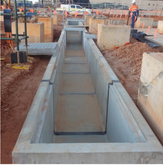
Precast units for LNG processing train
