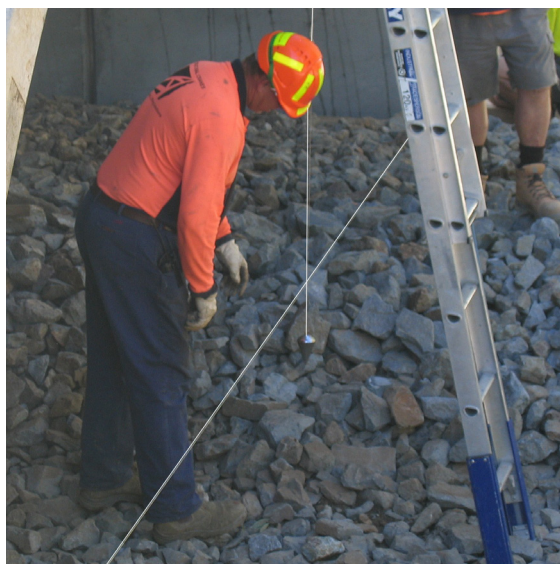
Top: Checking plumb before unhooking crane
